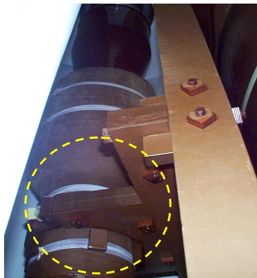
Figura 10 – Detalhe da parte inferior da bucha
